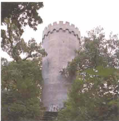
Vandtårnet i Brede blev opført i 1907 i "borgstil" med pudset mur og med fremtrukken kreneleret murkrone.
